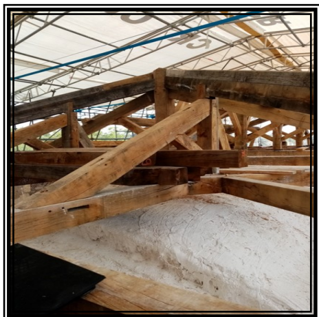
La voûte vue dessus de la charpente en cours
