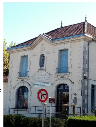
Réfection des zincs de la toiture de la Maison des Associations
