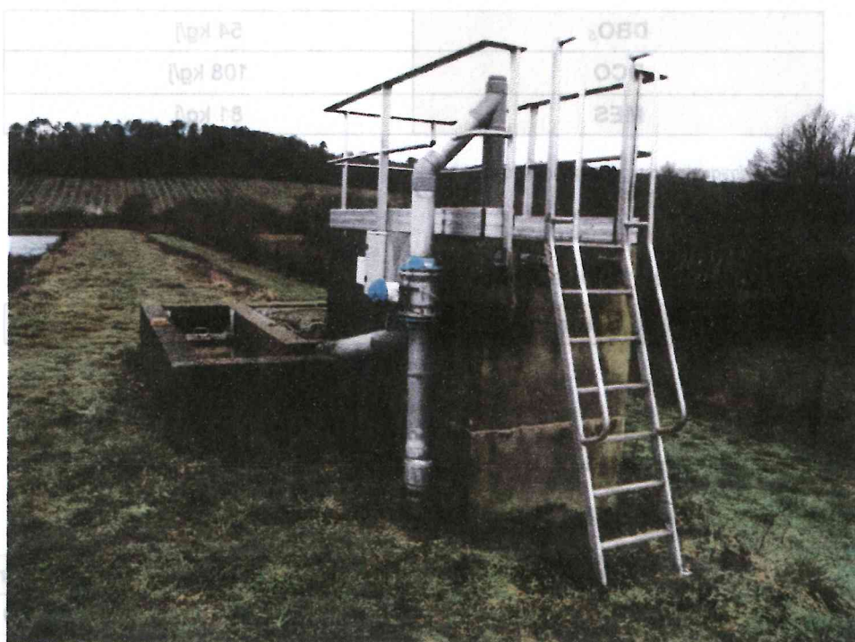
Vue sur l'ouvrage de prétraitement
